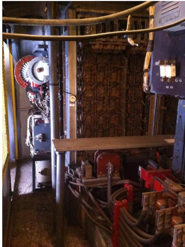
**Рисунок 4.5 – Тиристорный выпрямительно-инверторный преобразователь для питания вспомогательного тягового электрического двигателя**
